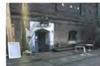
THE DIJK MAIN ENTRY DOOR 51 (pic 3-10-93 /to EES)
