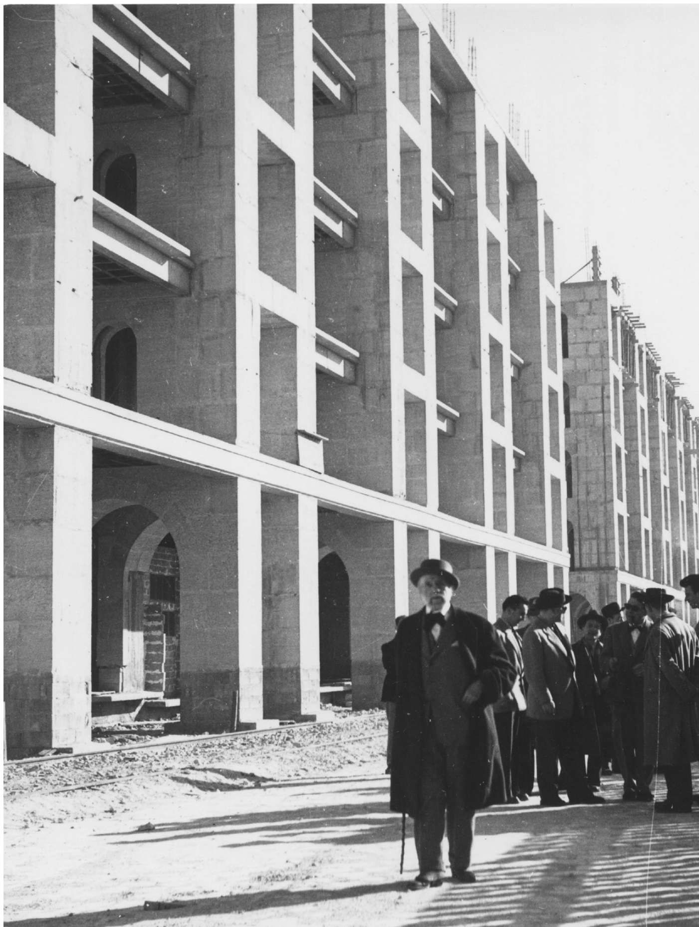
Le Vieux-Port (1951 CE) - Fernand Pouillon - Marseille, FR
